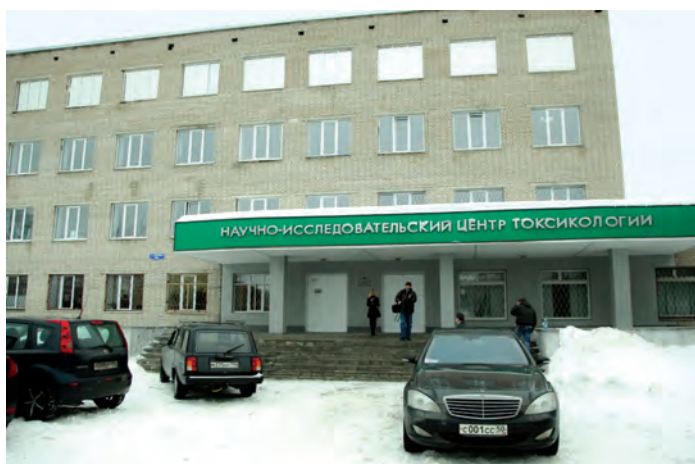
Здание НИЦ ТБП.
